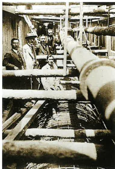
かみでんまちょう かやまち 上传馬町と萱町の工事
