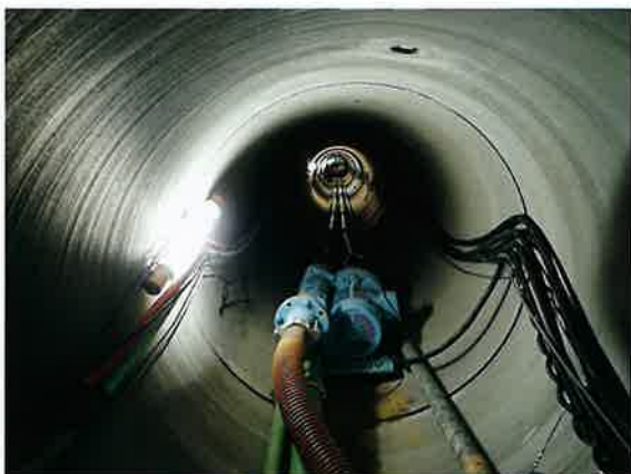
の なかじま おすいかんせん 2015年(平成27年) 野田・中島汚水幹線工事 ちよっけい 直径1.5mの下水道トンネル工事
