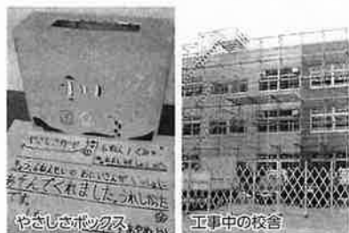
工事中の校舎
