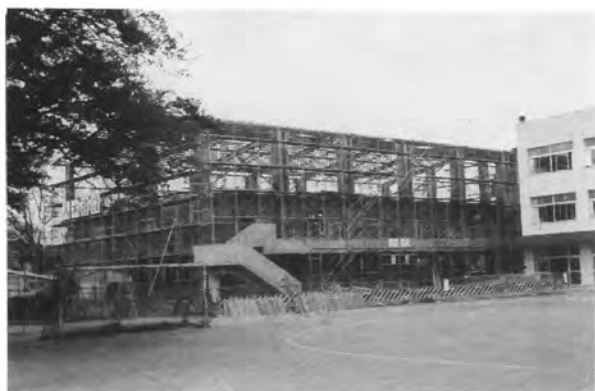
建設中の新体育館
