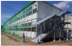
大型改修工事
